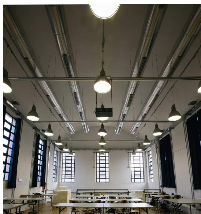
**La cloche Minni est livrable équipée en LED, avec réflecteur en aluminium poli anodisé de très haute finition ou en acrylique.**
